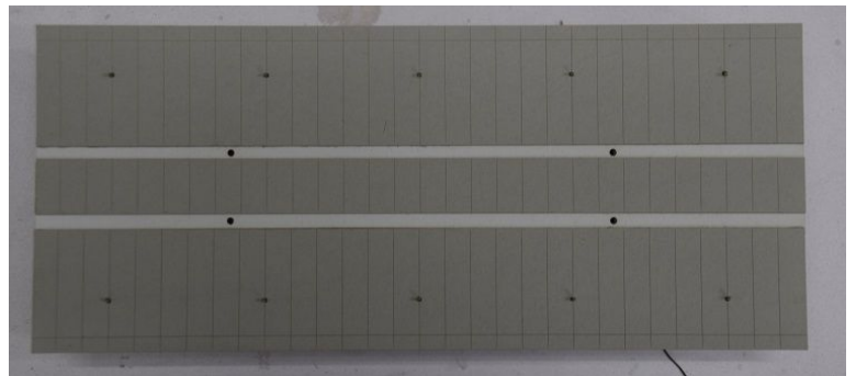
Bild 17 wenn auf der Gegenüberseite die Beleuchtung Eingebaut ist, kann der restliche Dachteil montiert werden
